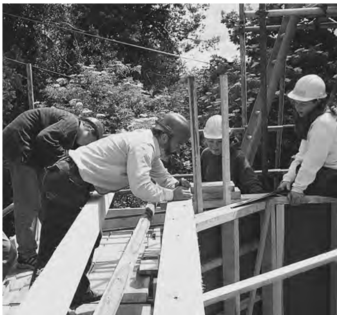
Proyecto de construcción en secundaria.
